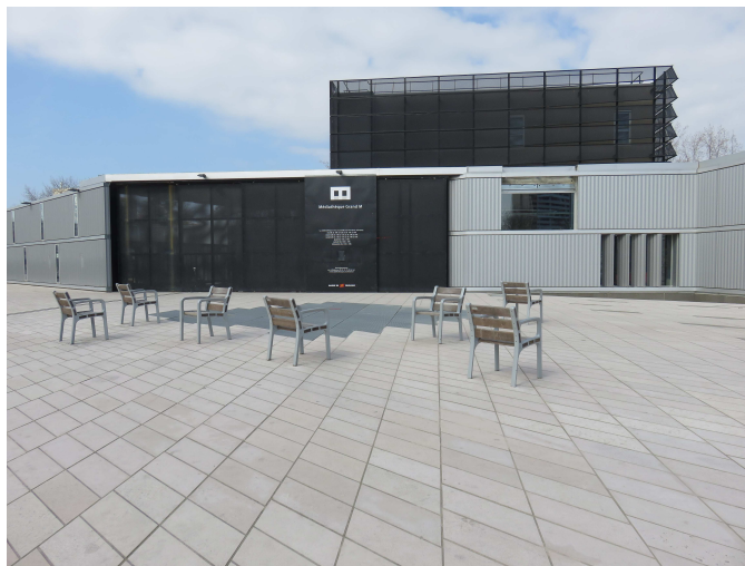
photogr. 2 : Médiathèque Grand M : parvis et entrée
