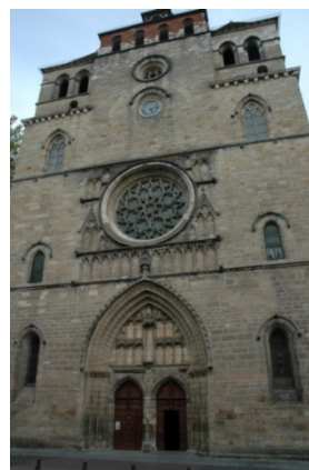
Figure 124 : Façade occidentale de la cathédrale Saint-Etienne de Cahors, portail sur lequel des traces de polychromies et de dorures ont été découvertes
