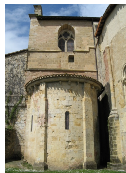
Figure 106 : Absidiole sud, vue de l'extérieur
