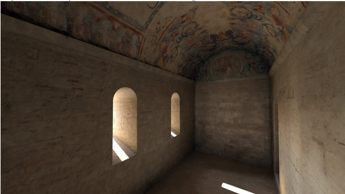
Figure 437 : Vue du côté ouest. La scène de David ainsi que la partie sud de la voûte ont retrouvé une partie de leur décor.
