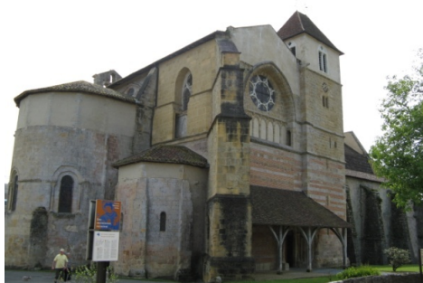
Figure 105 : Vue générale de l'église, entrée nord
