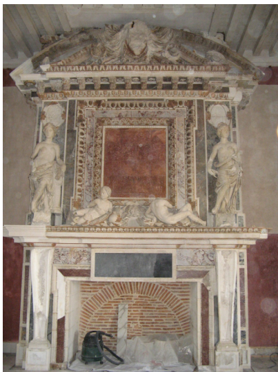
Figure 25 : Cheminée de la salle des appartements du Roi, 1 er étage (salle 3)
