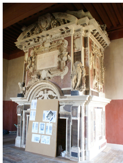
Figure 26 : Cheminée de l'antichambre du Roi, 1 er étage (salle 4)
