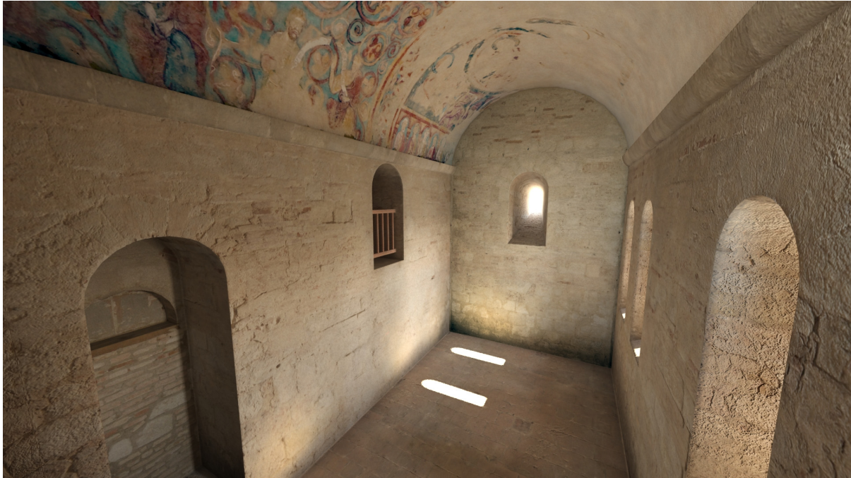
Figure 433 : Vision de la chapelle au XIX e siècle vers l'est. La dépose du plancher et les nombreuses ouvertures ont provoqué une instabilité du microclimat, affectant la conservation des peintures.
