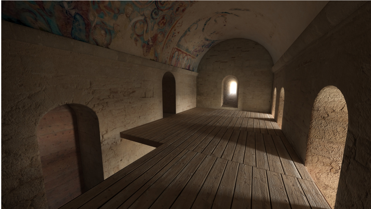
Figure 434 : Etat de la chapelle entre le XV e et le XVIII e siècle. La pose d'un plancher la sépare en deux niveaux. Vue de l'étage. La hauteur permet de se tenir debout, l'éclairage est suffisant et rend la pièce tout à fait utilisable.
