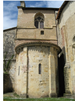
Figure 106 : Absidiole sud, vue de l'extérieur
