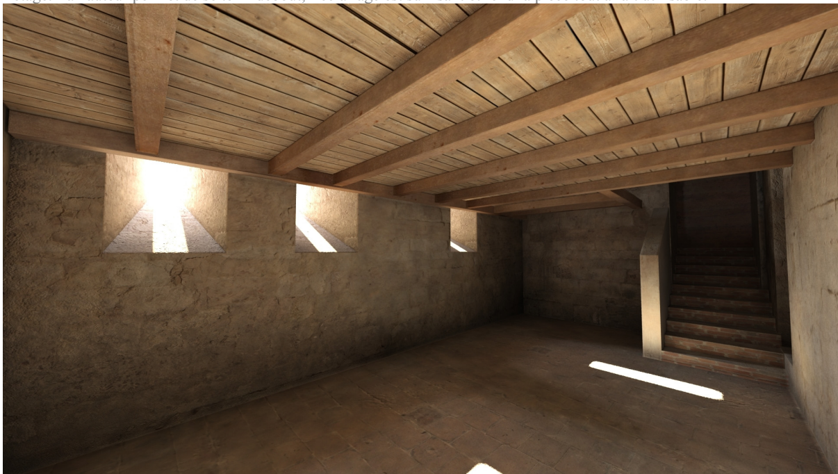
Figure 435 : Etat de la chapelle entre le XV e et le XVIII e siècle. La pose d'un plancher la sépare en deux niveaux. Vue du rez-de-chaussée où l'on peut tenir debout. Les trois fenêtres du mur sud laissent entrer suffisamment de lumière.
