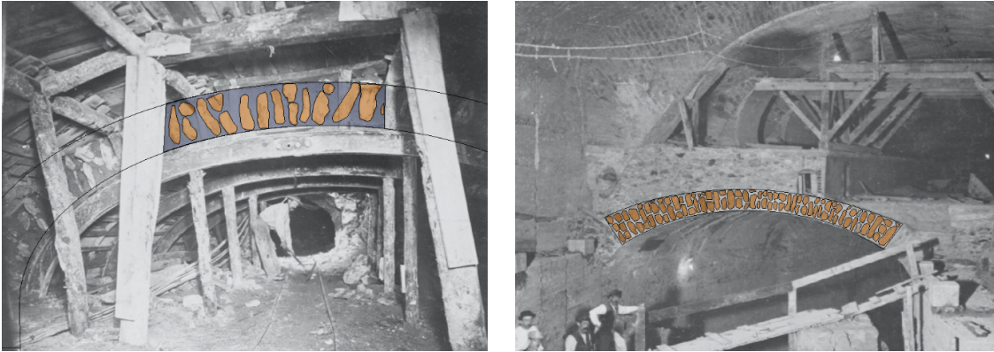
Figure 2.4 – Étude photographique de l'appareillage de la maçonnerie des voûtes du métro parisien.
