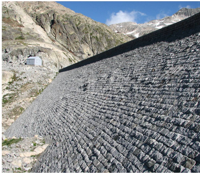
Figure 3.1 – Barrage EDF de Portillon (Haute-Garonne) en enrochement avec perré en pierre sèche.
