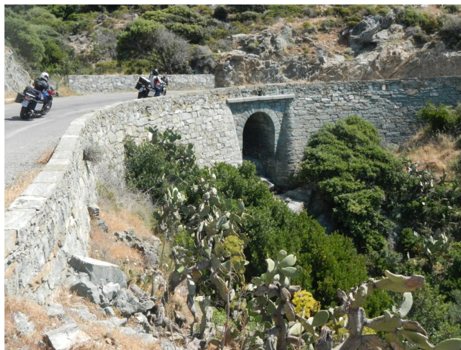
Figure 1.1 – Route aménagée par des murs en pierre sèche au Cap Corse (Haute-Corse).
