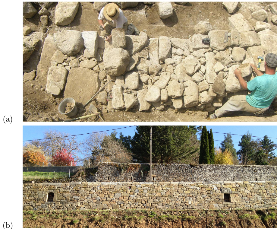
Figure 4.3 – Construction (a) et vue du mur de soutènement en pierre sèche de Felletin en Creuse (b).
