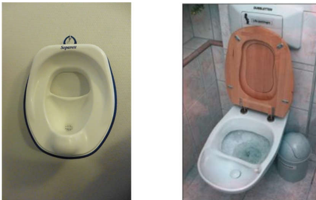
Figure 4.15 : Dispositifs d'adaptation des toilettes à séparation d'urine pour les enfants. À gauche, siège amovible de marque Separett (source personnelle) ; à droite, double lunette adulte et enfant du modèle Dubbletten (source : Johansson et al. , 2000).
