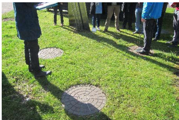
Les réservoirs de stockage
