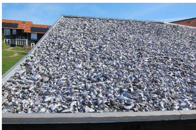
Le ralentissement des eaux de pluie avec des coquilles de moules
