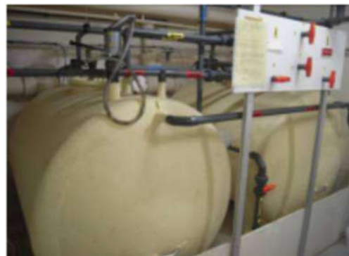
Figure 4.16 : Toilette à séparation d'urine et cuve de stockage d'urine de l'unité de médecine nucléaire de l'hôpital de la Pitié-Salpêtrière (Paris).
