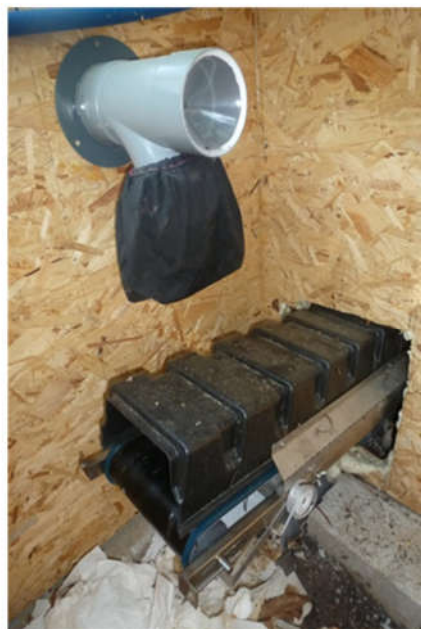
Figure 4.17 : Toilette à séparation d'urine à tapis roulant.
