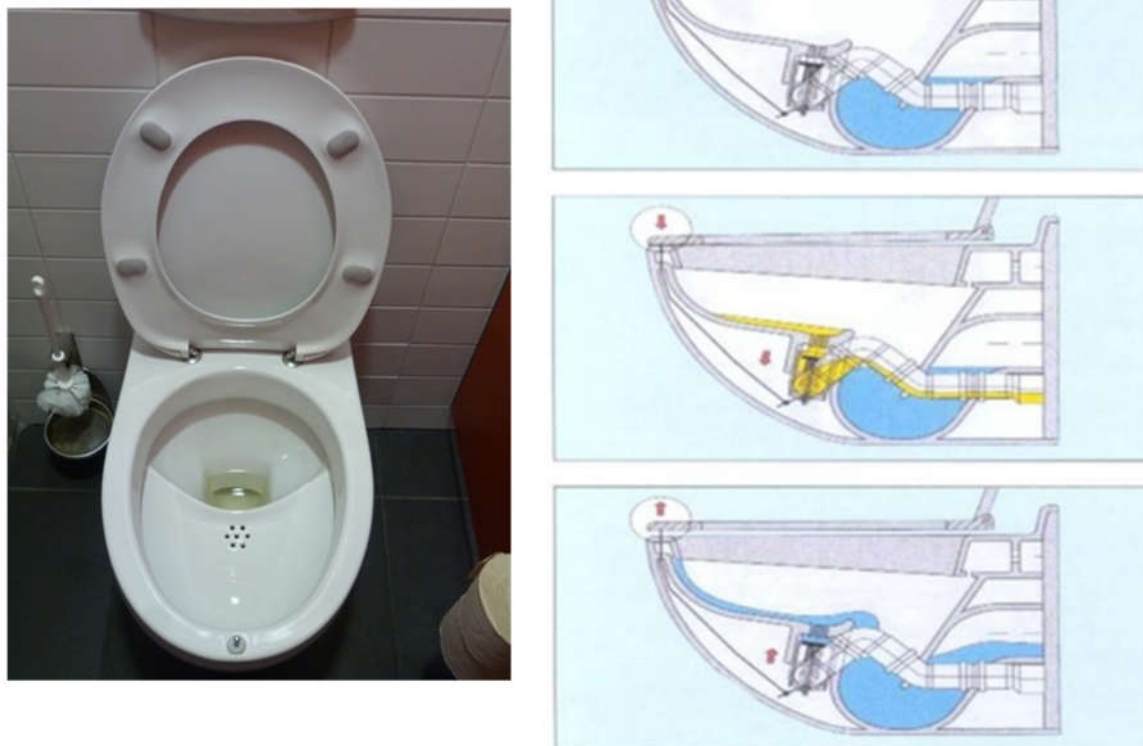
Figure 4.13 : Toilette à séparation d'urine No Mix.
