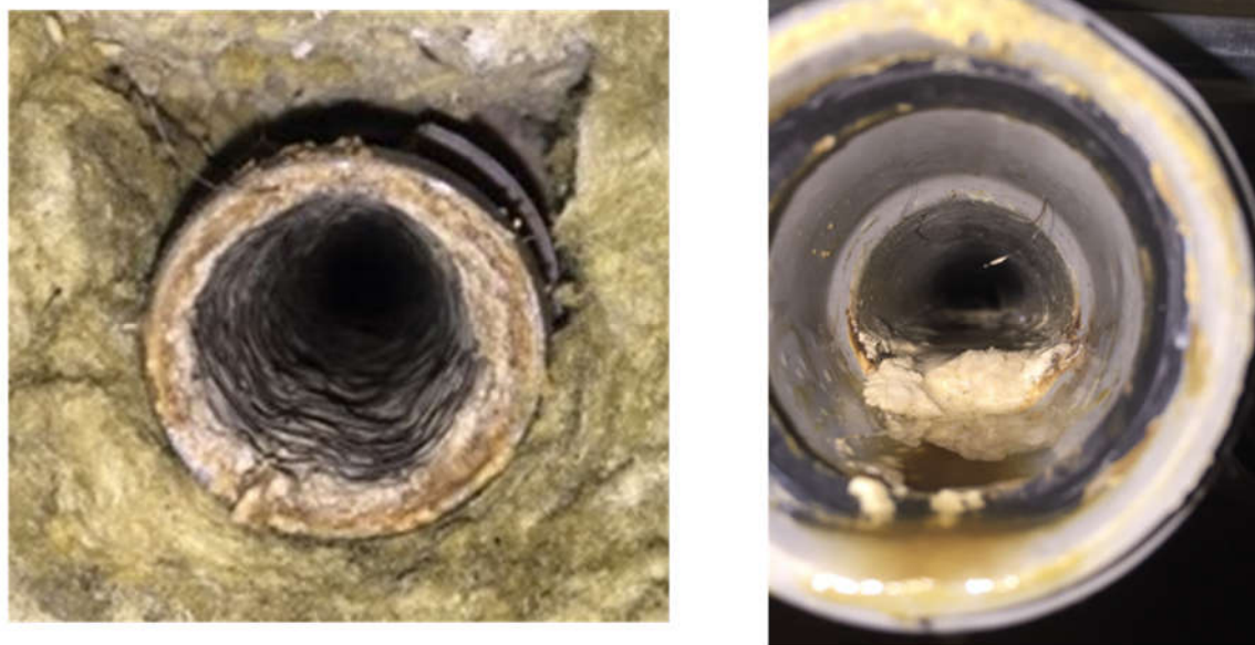
Figure 4.19 : Précipitations dans des tuyaux de collecte d'urine (source personnelle).
