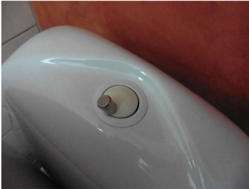
Figure 4.12 : Détail du bouton de chasse d'eau de toilettes à séparation d'urine.
