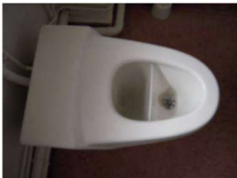
Figure 4.16 : Toilette à séparation d'urine et cuve de stockage d'urine de l'unité de médecine nucléaire de l'hôpital de la Pitié-Salpêtrière (Paris).
