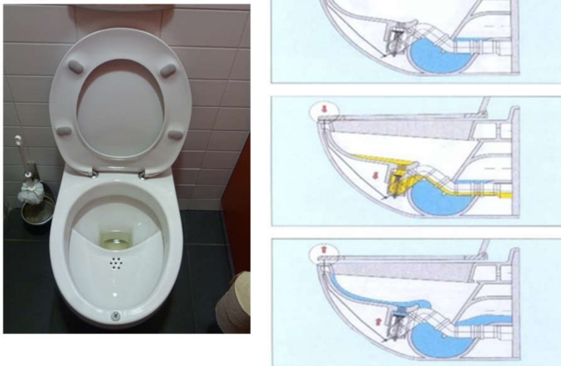
Figure 4.13 : Toilette à séparation d'urine No Mix.
