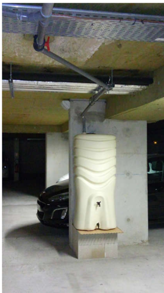
Figure 4.25 : Cuve de stockage du projet Azuris lors de son installation.
