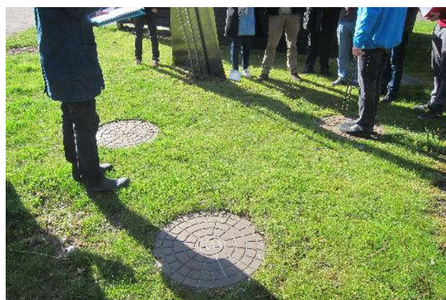
Les réservoirs de stockage
