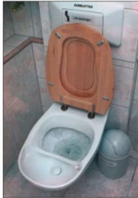
Figure 4.15 : Dispositifs d'adaptation des toilettes à séparation d'urine pour les enfants. À gauche, siège amovible de marque Separett (source personnelle) ; à droite, double lunette adulte et enfant du modèle Dubbletten (source : Johansson et al. , 2000).
