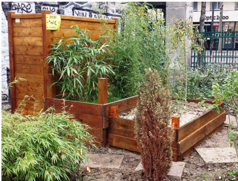
Figure 4.9 : Urinoir temporairement installé dans le square du jardin Saint-Laurent à Paris IX e .
