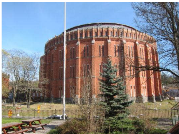
Ancien stockage de gaz.
