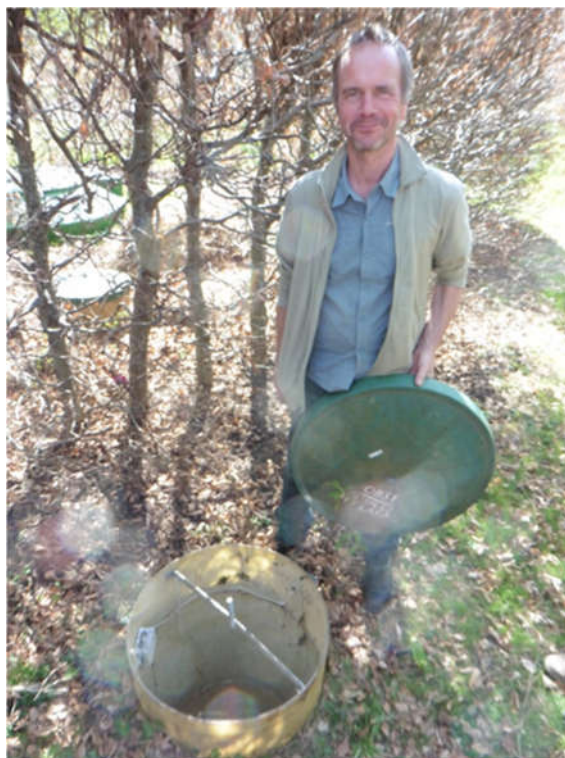
Figure 4.27 : Habitant d'Understenshöjden devant le regard d'une des cuves de stockage d'urine.
