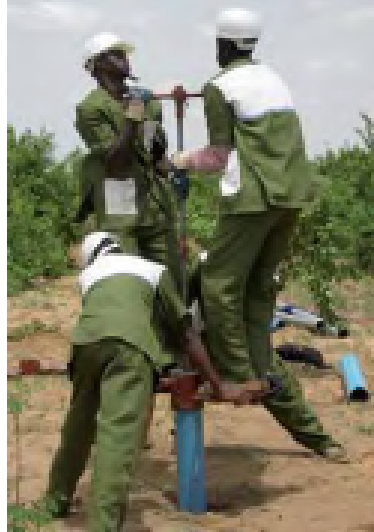
FIGURE 2.2 – Forage à la terre manuel
