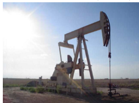
Système de pompage
