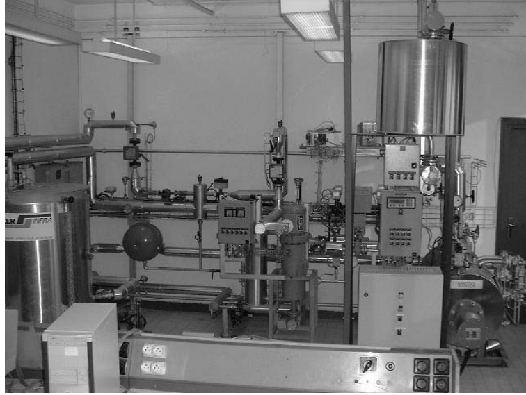
FIG. 4.20 – L'installation du générateur de vapeur
