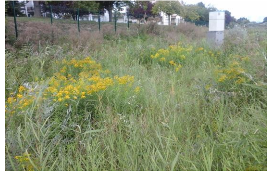
(b) Filtre planté de roseaux
