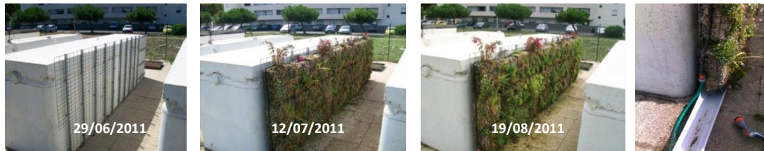
Figure 62 - Mise en place d'un système de façade végétalisée
