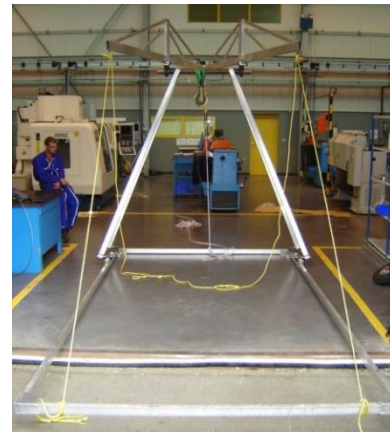
Figure 152 : Réalisation du palan
