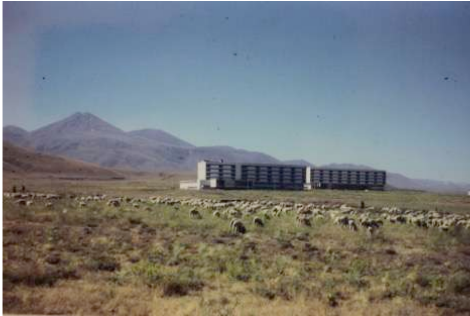
Figure 23 : photographie des bâtiments en construction de l'université d'Erzurum en 1965 200
