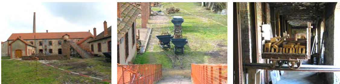
Figure 15 : L'ancienne fabrique de Ciry-le-Noble
