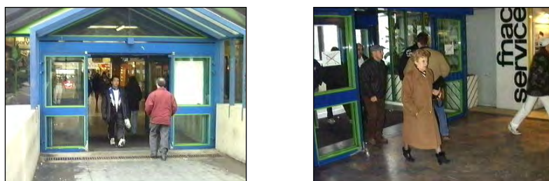
Figure 4 : Sas composé par un double système de portes automatiques Centre commercial Grand-Place – Grenoble Sud
