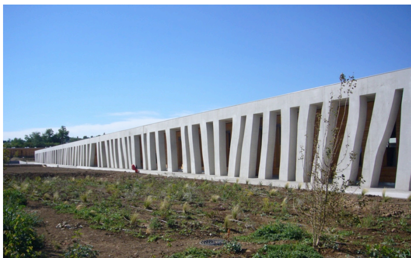
Rudy Ricciotti, Cité Scolaire de Manosque, Pportique extérieur
