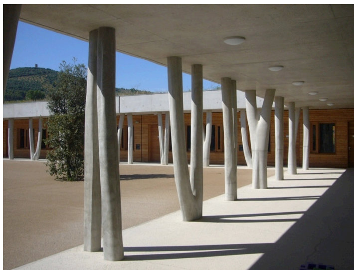
Rudy Ricciotti, Cité Scolaire de Manosque, pèaux intérieures
