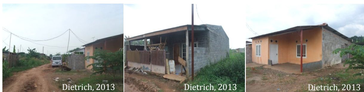
Photographies 23 a b et c : Nouvelles maisons en construction au sud de Bintara
