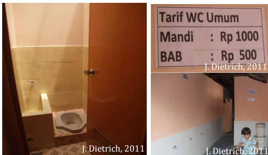
Photographies 17 : Les latrines communes – MCK – à Warung Gantung pour la douche (mandi) les toilettes (BAB) et la lessive
