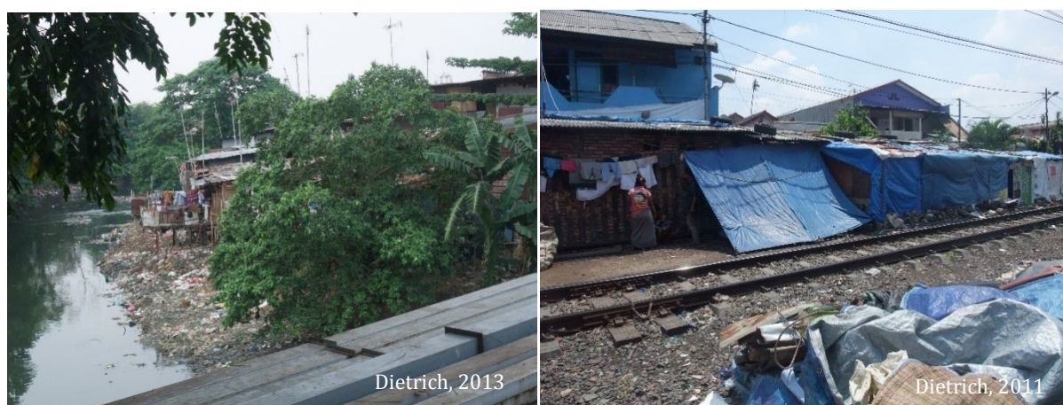
Photographies 6 : Deux types de constructions « informelles » a. le long de la rivière Ciliwung, Manggarai b. le long du chemin de fer, Senen
