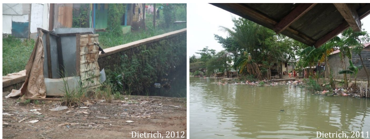
Photographies 37 : Toilettes hélicoptères a. à Bintara (sur le kali)
