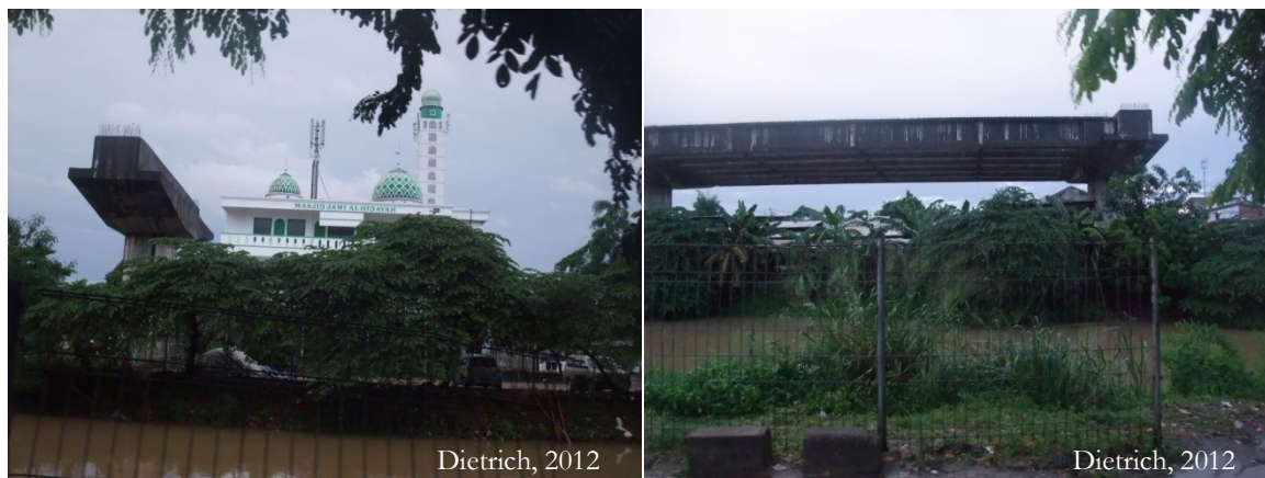
Photographies 30 : L'autoroute aérienne en cours de construction
