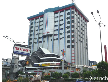
Sarinah, premier supermarché dans le nouveau centre sur la Jalan Thamrin, construit en 1962
