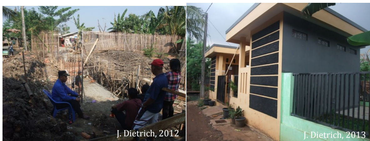
Photographies 19 : Le MCK de Bintara, en construction (juillet 2012) et finalisé (juin 2013)
