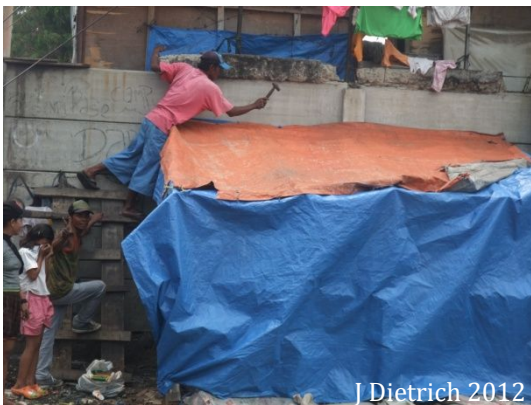
J Dietrich 2012 Construction d'un abri sous bâche le long du mur entourant les voies de chemin de fer
