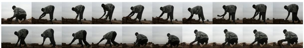
Figure 73 - Le « maçon funambule », travaille en marche arrière debout sur le mur.
