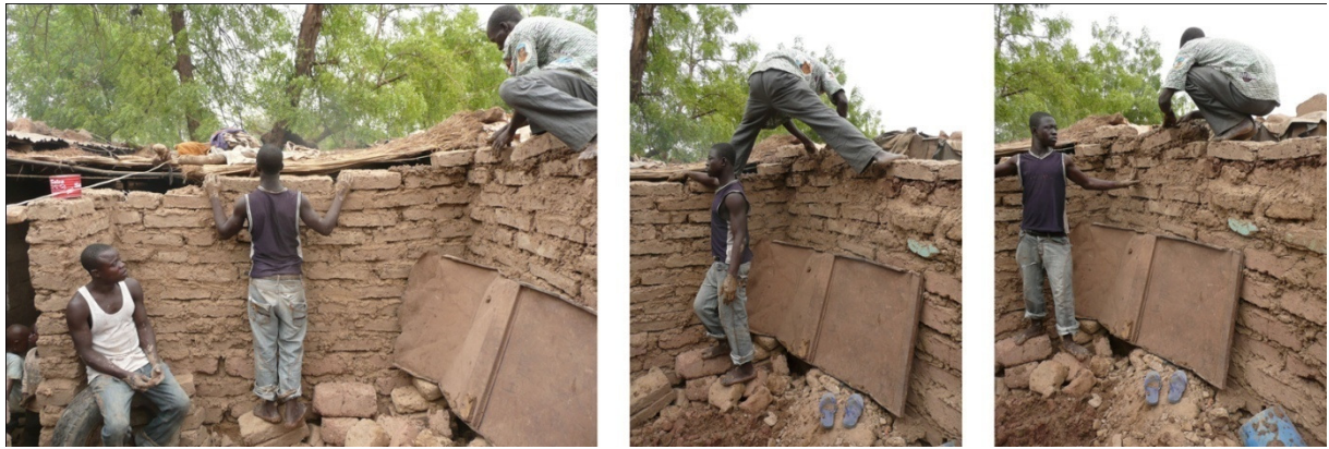
Figure 71 - Le maçon travaille debout sur le mur
