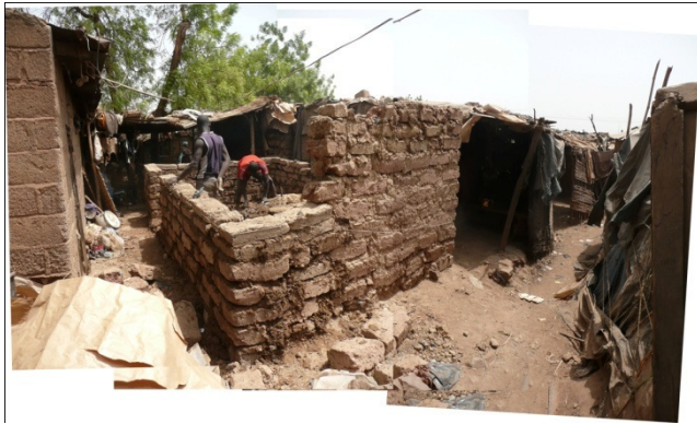
Figure 61 - Sixième rang de briques et vérification de l'alignement
