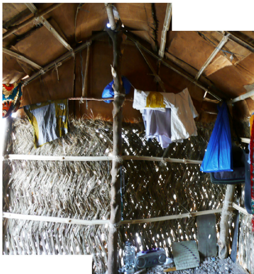
Panoramique intérieur de la construction
