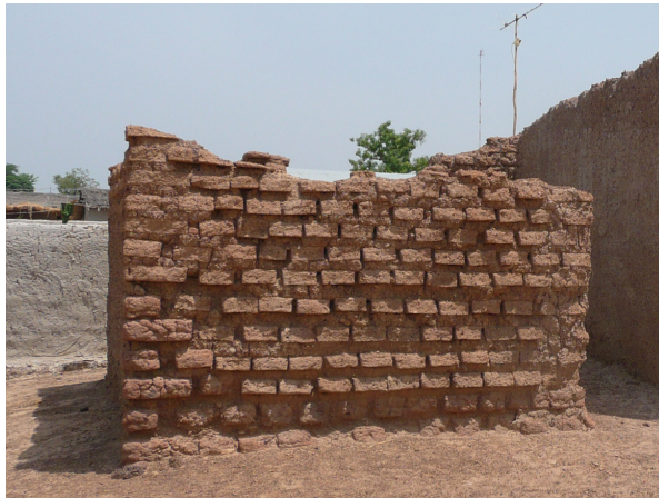
Mortier plus fragile que les briques
