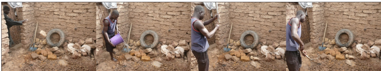
Figure 79 - Apport, humidification et concassage
