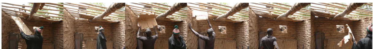
Figure 92 - Disposition des cartons
