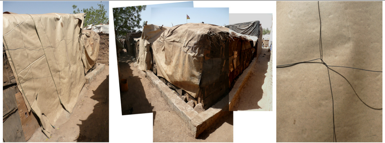
Figure 34 - « Empaquetage » d'une architecture avec du papier pour une phase transitoire (B.7)
