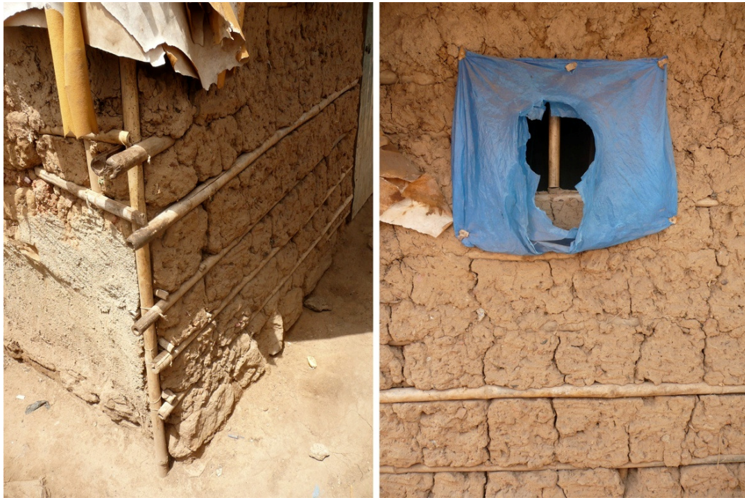
Figure 119 - Détail de construction en « Poto-Poto »
