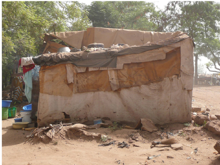
2009, Addition d'une nouvelle enveloppe
