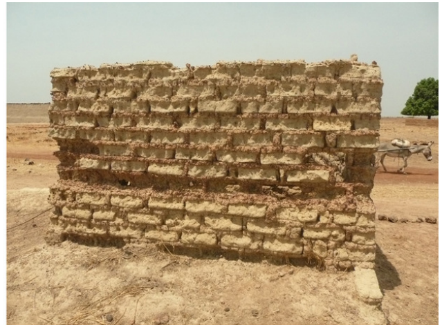
Briques plus fragiles que le mortier
