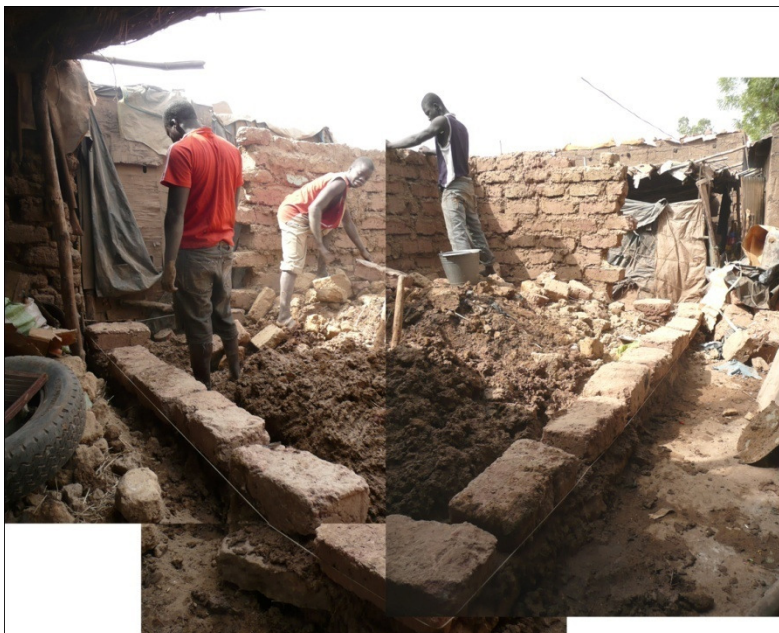
Figure 56 - Premier rang de brique et vérification de l'alignement
