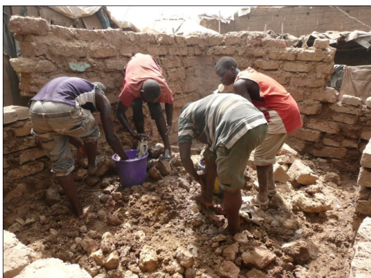
Figure 63 - Les jeunes maçons se lavent sur le tas de mortier, par souci d'économie
