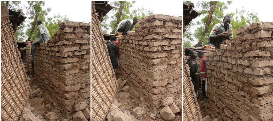
Figure 76 - Pose cigarette (à gauche) et travail sur les 6 rangs de briques fraîchement posées le matin
