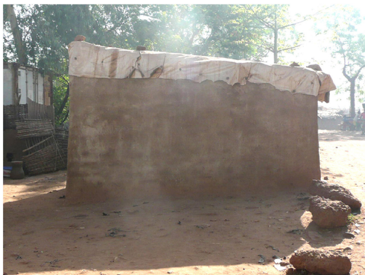
2012, Changement du sens de la pente et (re)construction en terre
