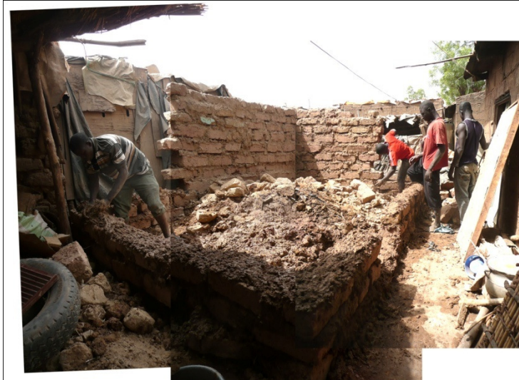
Figure 58 - Deuxième rang de briques et nouveau lit de mortier
