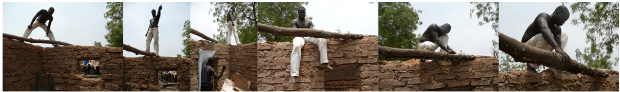
Figure 87 - Aboutage de deux poutres
