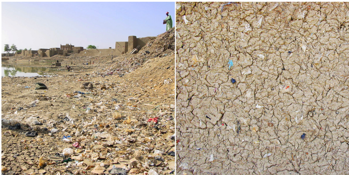
Figure 202 - Enduit extérieur d'une maison de la ville de Djenné (2008)
