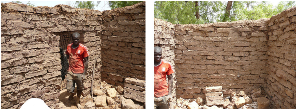
Figure 84 - Etat des lieux après trois dimanches de chantiers
