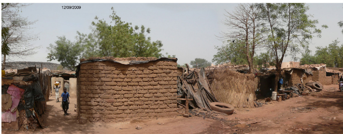
Chronophotographie de l'évolution de la construction de Ousmane Diarra (Vue depuis la rue principale)
