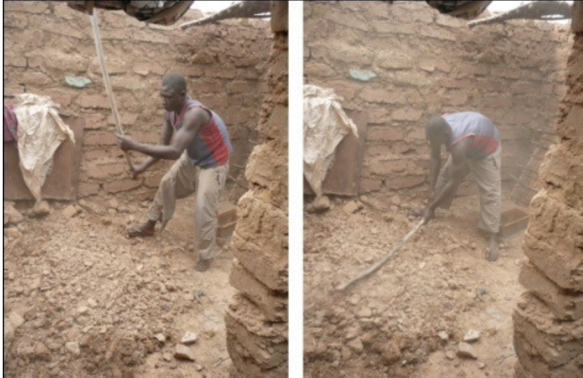
Figure 78 - Concassage de blocs de terre pour la préparation d'un mortier
