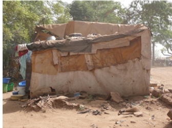
2009, Ajout d'une nouvelle enveloppe
