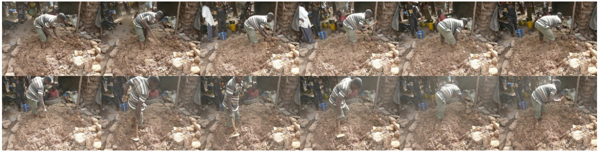
Figure 54 - Malaxage du mortier de terre
