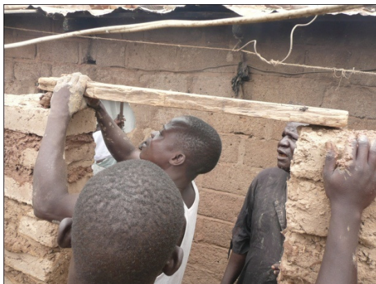
Figure 70 - Mise en place du linteau de porte
