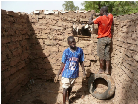
Figure 80 - Echafaudage à partir d'un pneu
