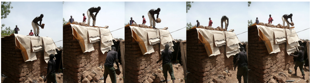
Figure 94 - Réalisation de l'acrotère pour palier à l'arrachement de la couverture
