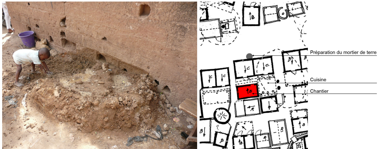
Figure 81 - Mortier spécial pour le haut du mur préparé en avance pendant plusieurs jours
