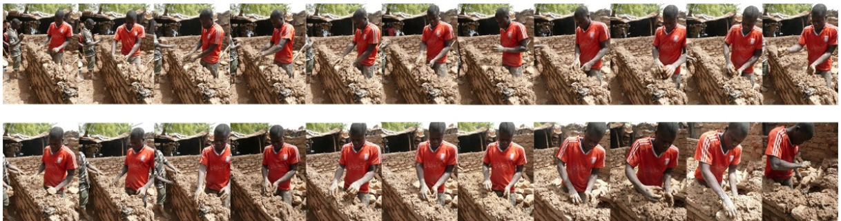
Figure 62 - Gestes de maçonnerie à mains nues
