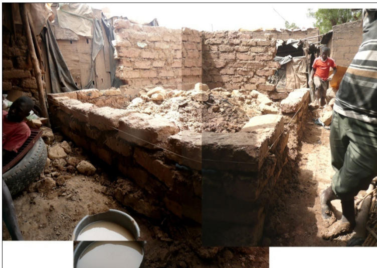
Figure 59 - Troisième rang de briques et vérification de l'alignement
