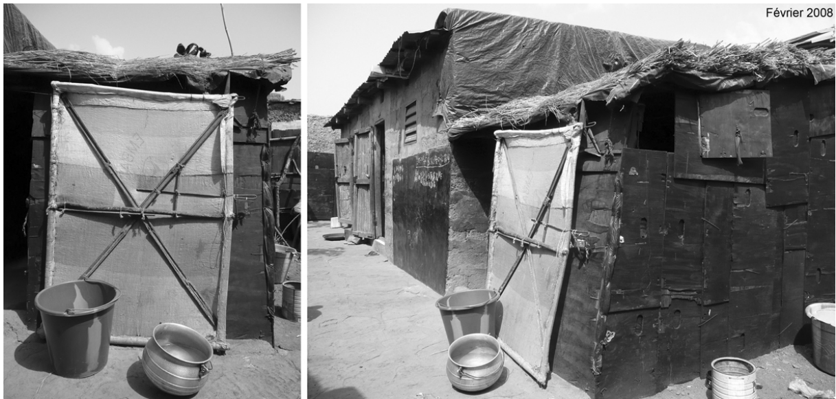
Figure 175 - Une porte ventilée
