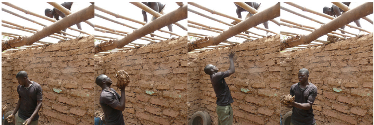
Figure 91 - Scellement des bambous au faitage
