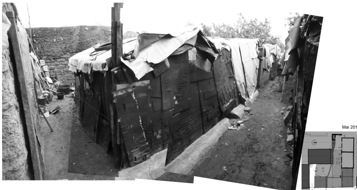
Figure 188 - Evacuation des eaux dans la ruelle
