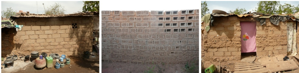
Figure 118 - Murs nomades - Parpaings maçonnés à la terre
