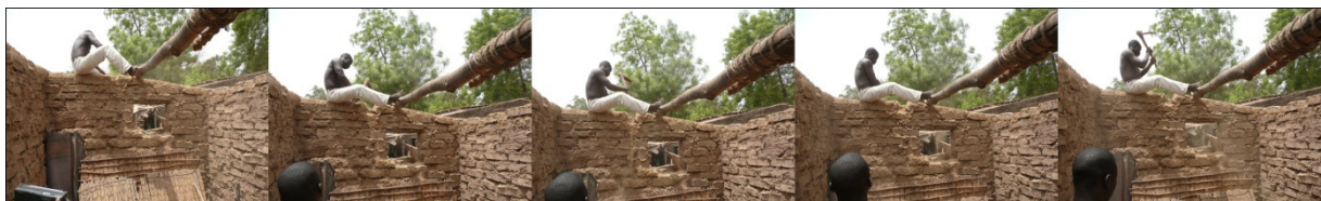
Figure 89 - Façonnage d'une réservation pour la poutre
