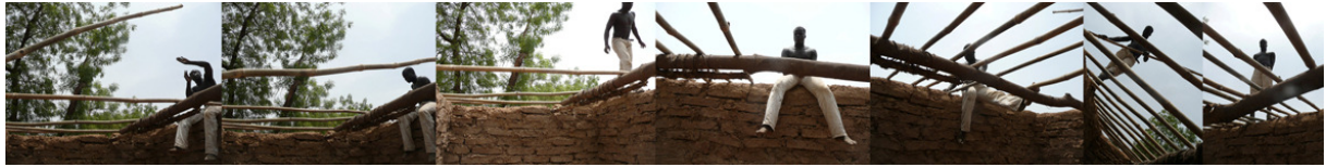
Figure 90 - Mise en place des bambous dans le sens de la pente
