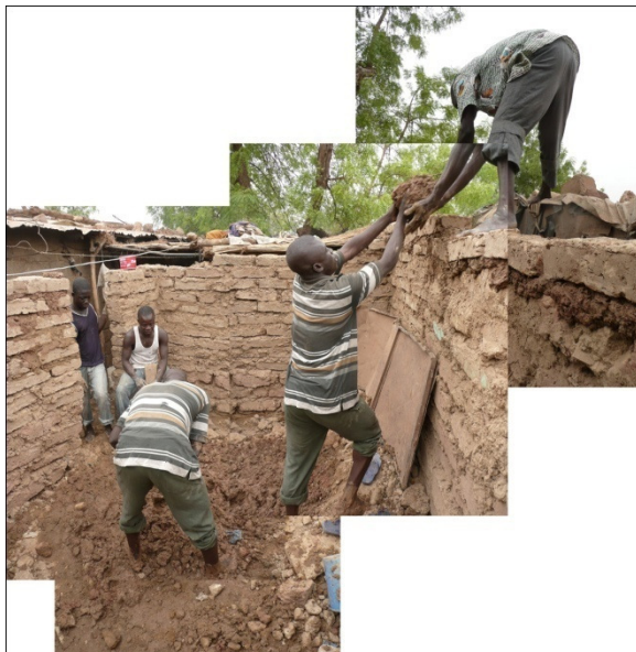
Figure 72 - On passe le mortier au maçon sur le mur
