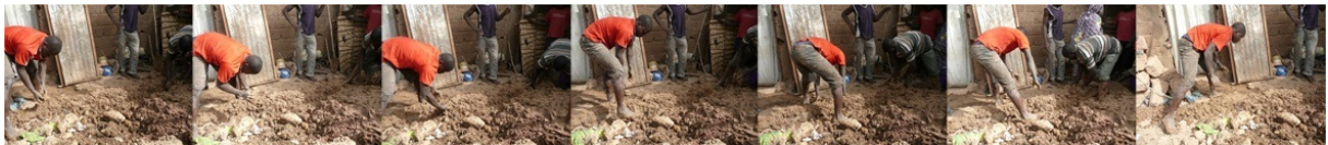
Figure 55 - Mise en place du premier lit de mortier à la main sur les pierres posées au sol
