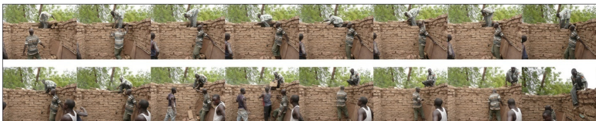
Figure 77 - Mise en place du quatrième et dernier mur
