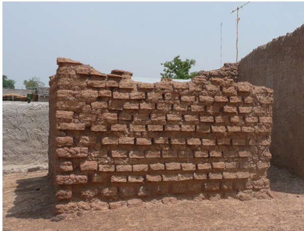
Mortier plus fragile que les briques
