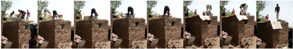
Figure 93 - Mise en place de la couverture de papier
