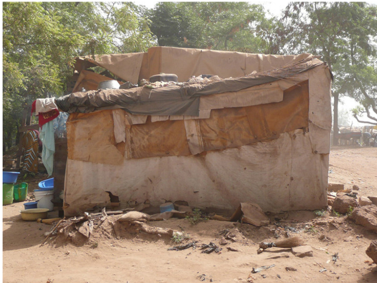
2009, Addition d'une nouvelle enveloppe
