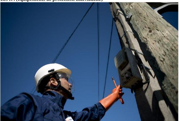
Travailler sur un réseau sous tension ou à proximité de celui-ci requiert de porter des équipements de protection individuelle. Sur la photo, on peut remarquer que le technicien porte la tenue réglementaire, des gants spéciaux et casque (avec la visière baissée).
