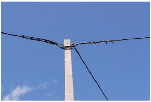
Les « fils » peuvent aussi être roulés en torsade et isolés. Dans ce cas-là, on parle de « réseau torsadé ». Même si le réseau est isolé, la prudence est de mise quand on s'en approche. En effet, l'isolation peut être abîmée à certains endroits.
