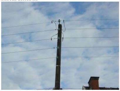
Ici, on peut voir 5 fils : 1 neutre, 3 phases et un  $4^{i eme}$  phase pour l'éclairage public. Le réseau est « nu », c'est-à-dire non isolé.
