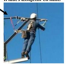
Quand on est dans sa position finale de travail, pour limiter la hauteur de chute en cas d'incident, il est important de s'assujettir au niveau de la tête et non au niveau des pieds.
