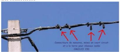
Le raccordement des câbles du groupe électrogène au réseau aérien se fait via des connecteurs.
