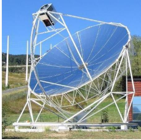
Figure 4 : Système Dish-Stirling CNRS-PROMES, (10 kW)
