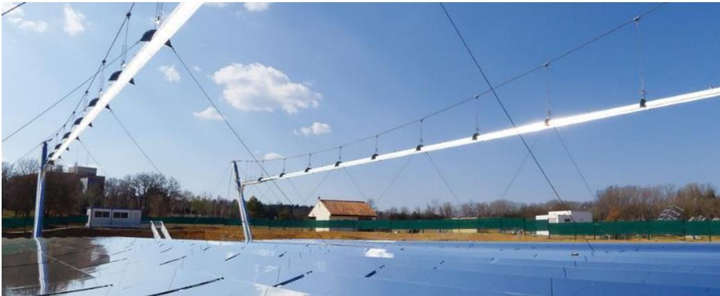
Figure 2 : Centrale CSP à miroirs de Fresnel Alsolen, France (500 kWth, ©Alsolen)
