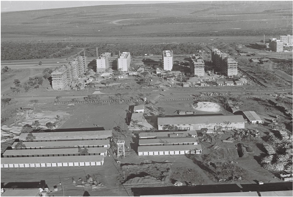
Figure 21 : Chantier de construction d'une superquadra
