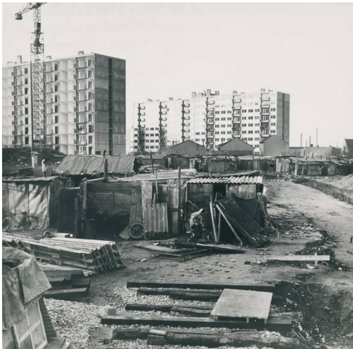
Figure 74: La démolition d'un bidonville et la construction d'une cité à Nanterre
