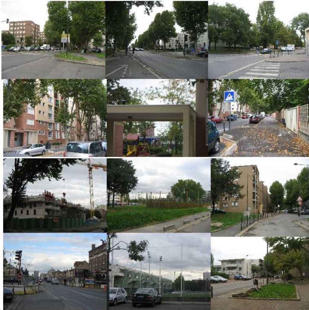
Ligne I/1- Avenue du Colonel Fabien (cité Delaune) vers l'Est 2- Avenue du Colonel Fabien vers l'Ouest 3-Avenue 19 mars 1962 Ligne II/1-Cité Hénaff 2- Cité Hénaff, vue sur la voie ferrée 3- rue Hénaff vers le Nord Ligne III /1-Construction de Front de Parc 2- Parc central ou place Sépard : le city-stade 3-rue Monmousseau vers le Nord Ligne IV/1- Avenue Stalingrad/RN vers le Nord 2-Stade Delaune 3-Rue Monmousseau vers le Sud
