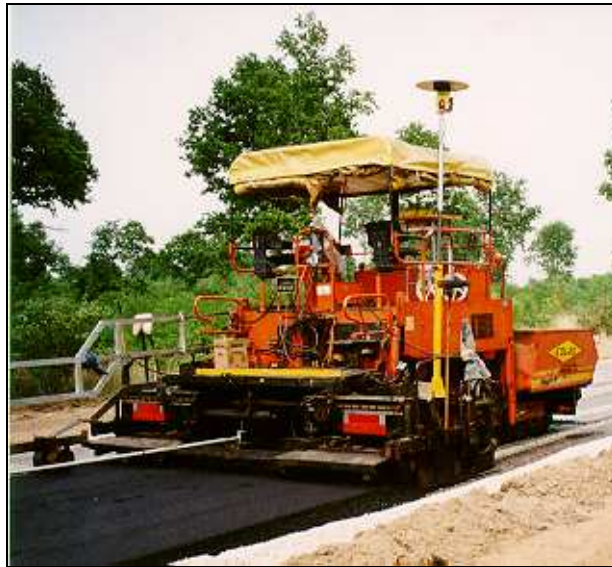
Figure 3.2 : chantier expérimental monté avec Colas pendant le stage de Gaëtan Hintzy
