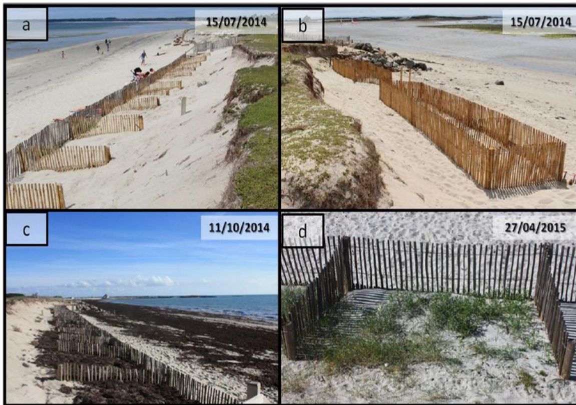
Figure 1. 41 : Deux types AlgoBox® installés en juillet 2014 sur la plage de Penvins dans le Morbihan, France ( a et b ) ; échouage massif d'algues rouges et remplissage des AlgoBox® avec S. chordalis ( c ) ; colonisation des AlgoBox® par la végétation ( d ) (Sedrati et Cochet 2015).
