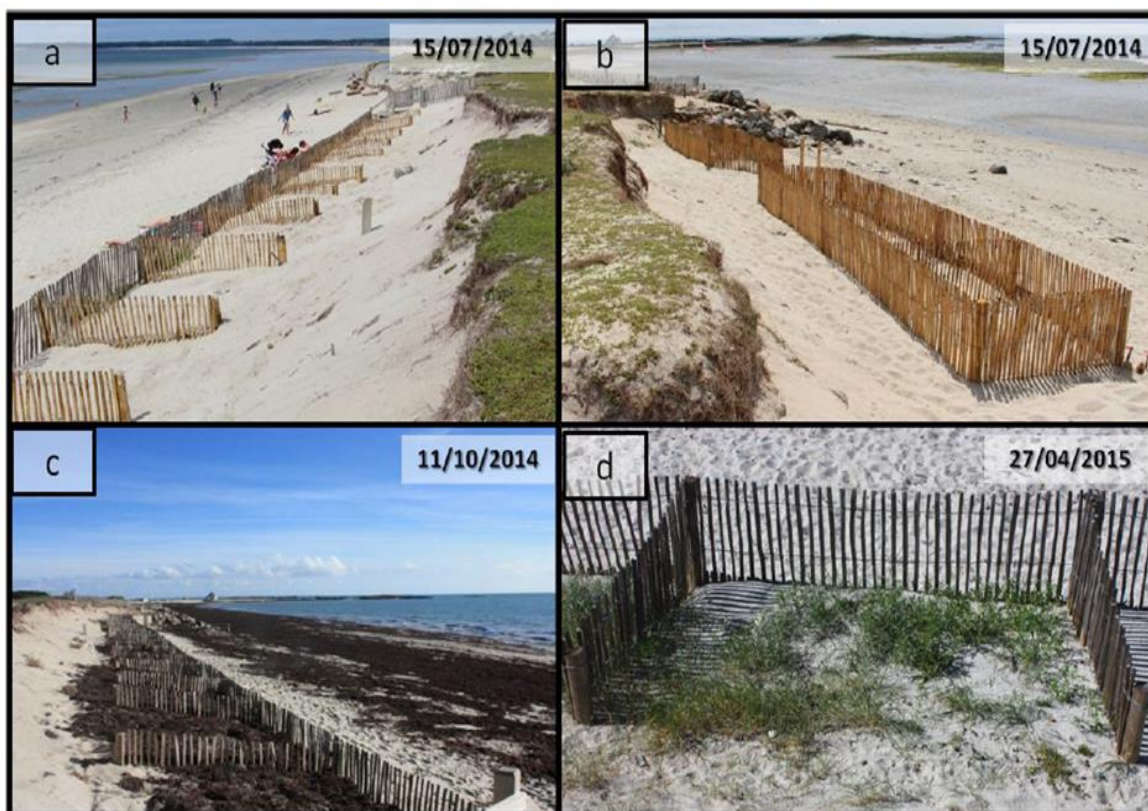
Figure 1. 41 : Deux types AlgoBox® installés en juillet 2014 sur la plage de Penvins dans le Morbihan, France ( a et b ) ; échouage massif d'algues rouges et remplissage des AlgoBox® avec S. chordalis ( c ) ; colonisation des AlgoBox® par la végétation ( d ) (Sedrati et Cochet 2015).
