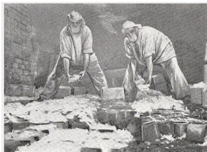
Figure I.5 : Le démontage de l'empilement : les ouvriers ne sont protégés que par de simples masques de tissu (Baty, 2012).
