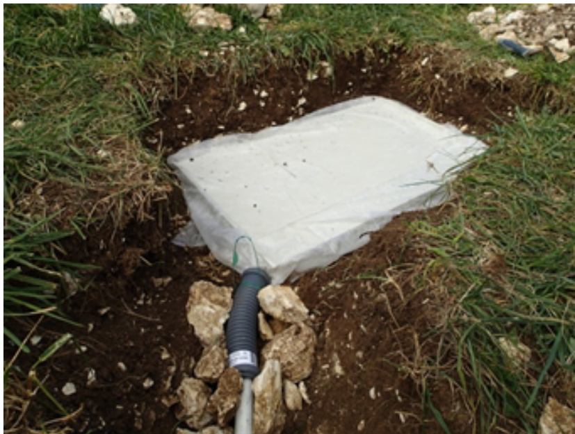
FIGURE II.31 – Plaque lysimétrique en cours d'installation dans un sol très superficiel avec au premier plan le raccord du tuyau de récolte ((Badot et al., 2016) et cliché : Eric Lucot)
