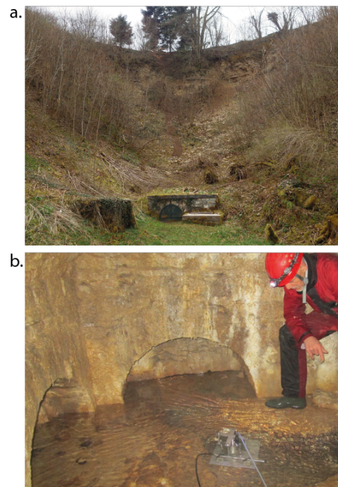
FIGURE II.14 – Captage de la source du Dahon (a) et fond du captage avec les arrivées d'eau (b)
