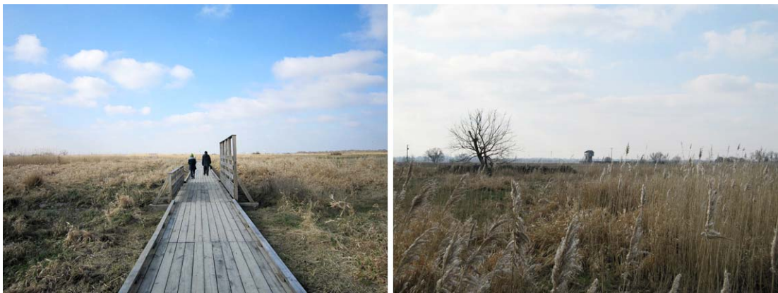
Photographies 20 et 21. - « L'observatoire », œuvre de Tadashi Kawamata à Lavau-sur-Loire. Le cheminement légèrement suspendu à travers des prairies humides typiques des paysages de l'estuaire pour accéder à l'observatoire et voir la Loire, se fait plus long et courbé immergeant le visiteur et lui offrant la surprise de l'apparition/disparition de l'objet à atteindre (clichés L. Ducasse, 2010).
