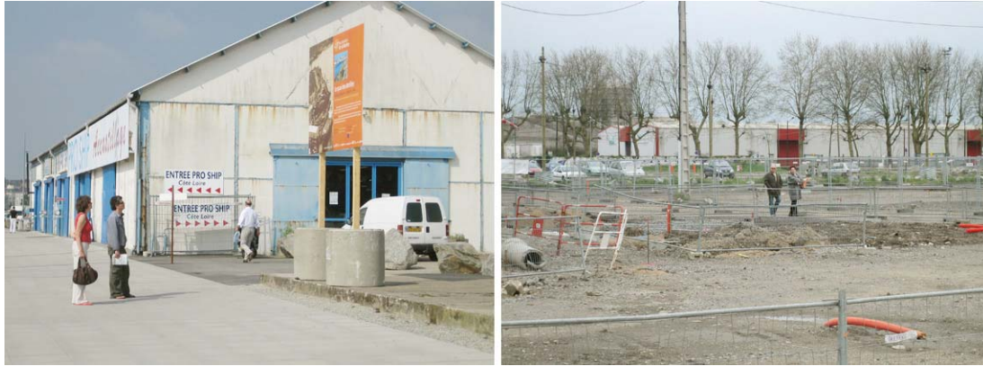
Photographies 15 et 16. – Visiteurs attendus sur le site en chantier.
