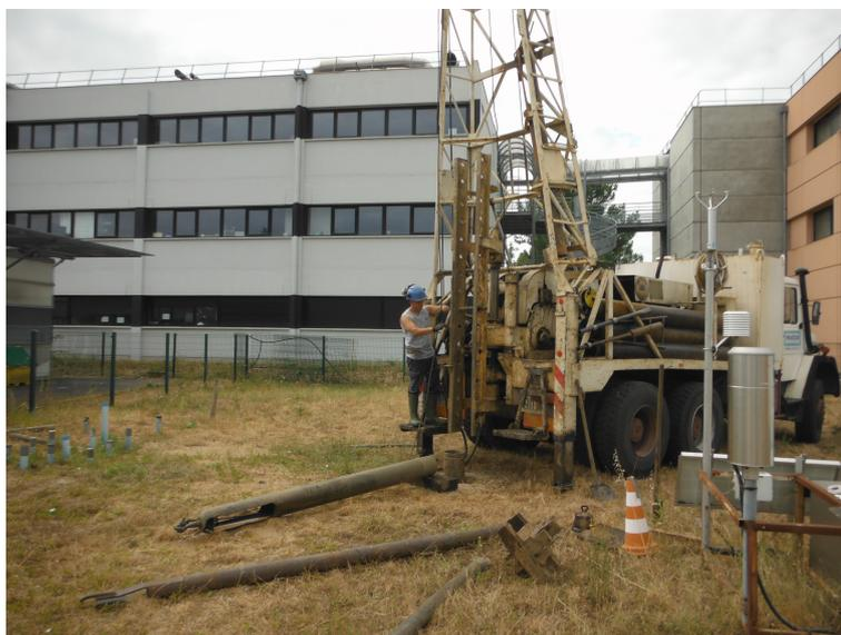
**FIGURE 5.4:** Réalisation des puits avec foration au battage et tubage à l'avancement
