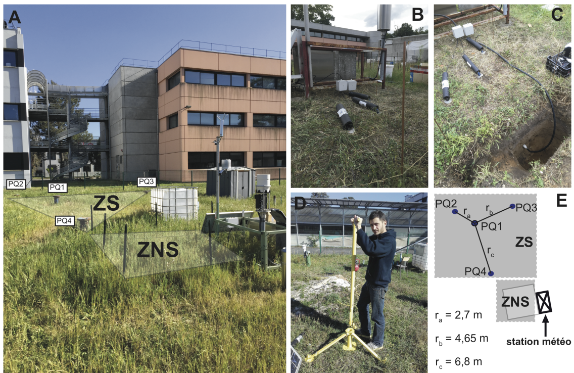
FIGURE 5.1: A : Vue d'ensemble de la station pilote avec suivi de la zone non saturée et station météo au premier plan et puits pour le suivi de la zone saturée au deuxième plan. B : Tensiomètres. C : Tensiomètres et installation des sondes de teneur en eau FDR. D : Installation des sondes de teneur en eau sentek ® . E : Schéma de situation de la station expérimentale avec (i) localisation du suivi de la zone non saturée (ZNS) et de la zone saturée (ZS) (ii) distances entre chaque puits ( r_a , r_b et r_c ).
