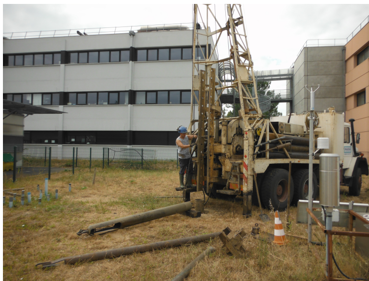
FIGURE 5.4: Réalisation des puits avec foration au battage et tubage à l'avancement
