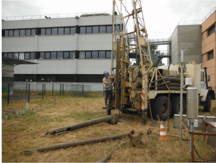
FIGURE 4.4: Réalisation des puits avec foration au battage et tubage à l'avancement
