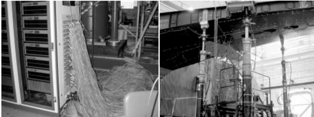
FIGURE 7 – Photos représentant le câblage nécessaire au suivi d'un essai sur une aile en composite. Le coût estimé pour les 182 jauges et leur installation représente un total de 10 000 $ [Childers et al. , 2001]
