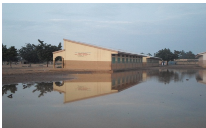
Photo 3: Complexe scolaire inondée à Madjécali Prise de vue : Koumassi, septembre, 2012
