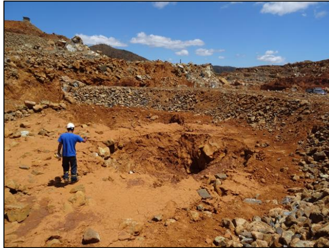
Figure 3 : Erosion interne au sein de la fosse Surprise, presqu'île de Bogota sur la côte Est.
