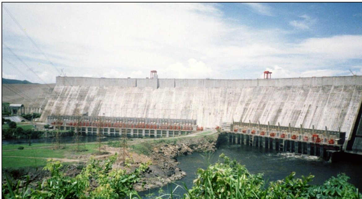
Photographie n° 5 : Le barrage hydroélectrique de Guri, en saison sèche.
