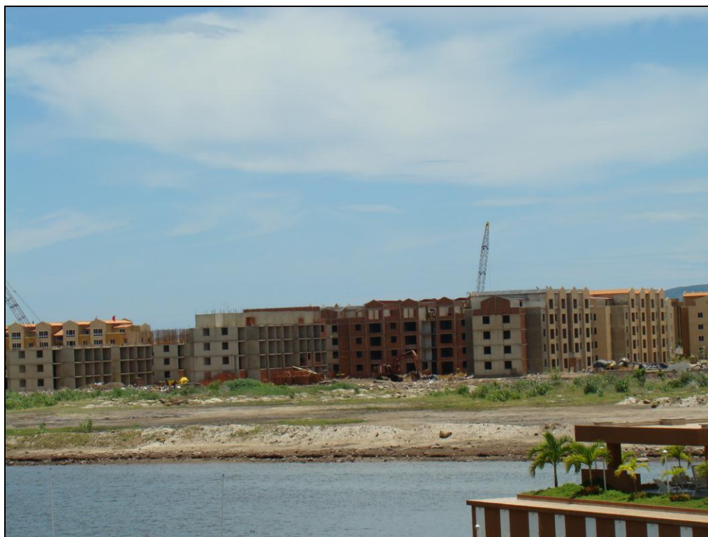
Photographie n°17 : Le chantier complexe résidentiel et touristique El Morro , en partie paralysé en 2007. Puerto-la-Cruz.
