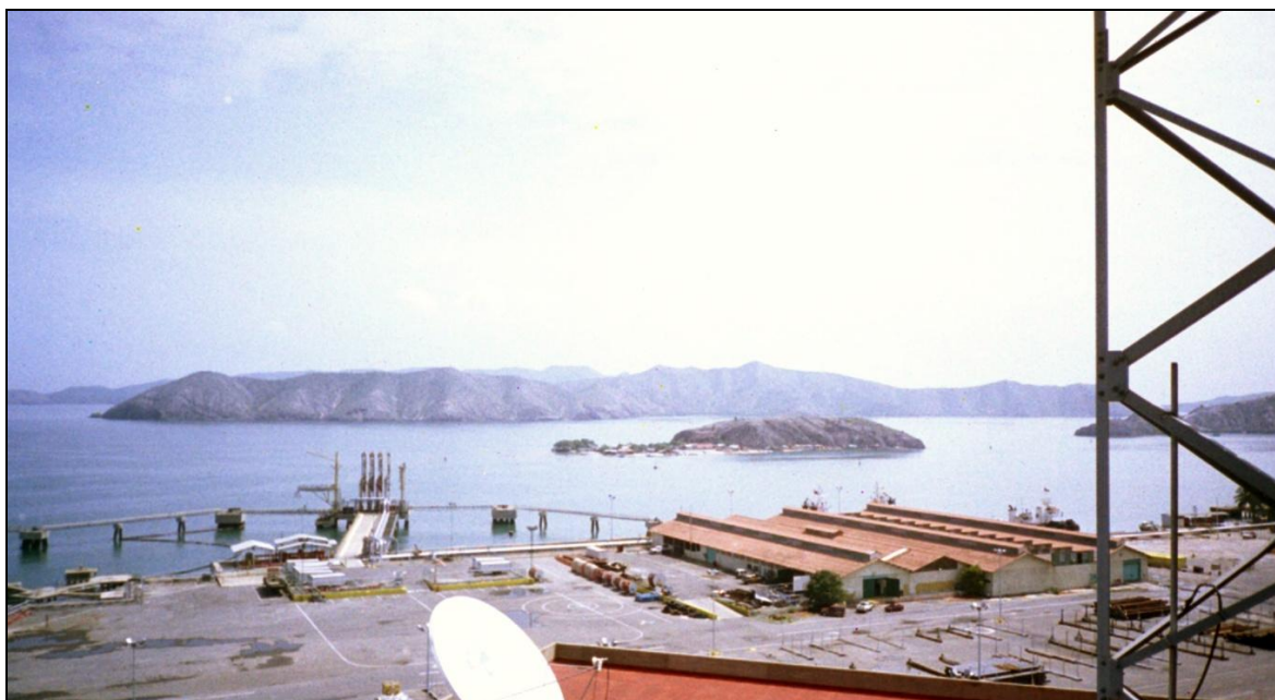
Photographie n° 9 : Terminal pétrolier de Guaraguao, Puerto-la Cruz.
