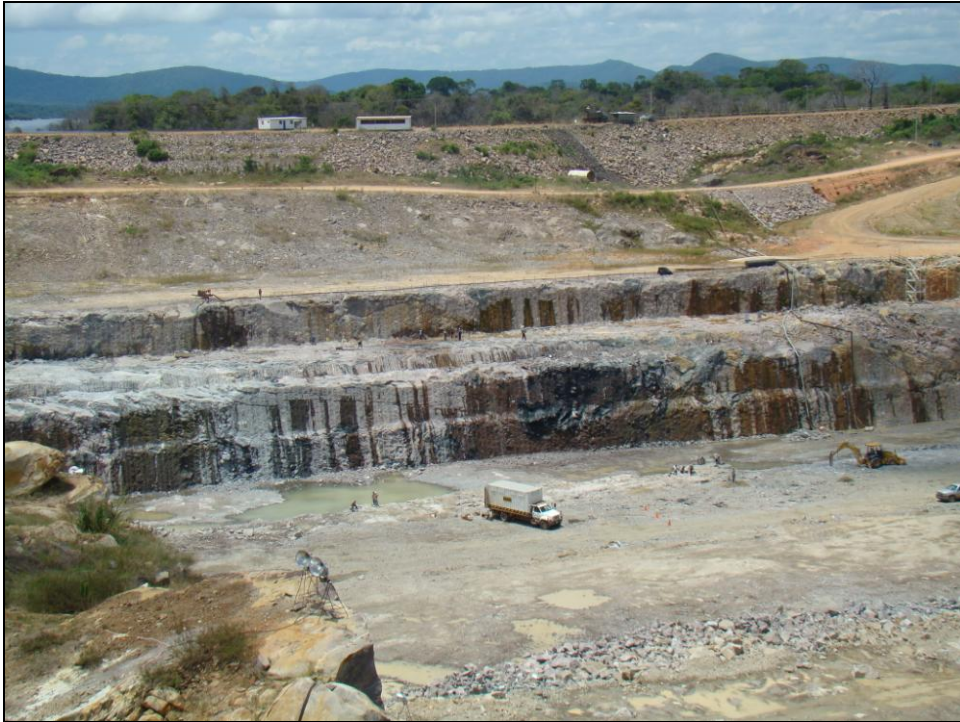
Photographie n° 6:Chantier de Tocoma, État Bolívar, en 2007.
