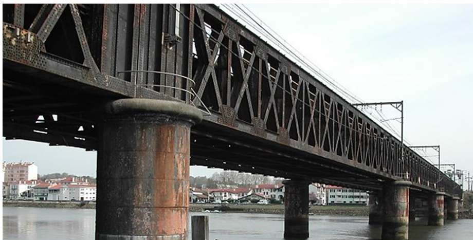
Figure 18: Pont de l'Adour, pont-rail SNCF
