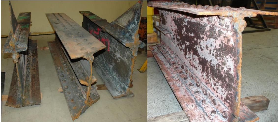
Figure 19: Poutrelles du pont de l'Adour fournies par la SNCF, décapées avant prélèvement de plaque pour essais
