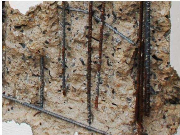
FIGURE A.6 – Les armatures du béton armé apparaissent et le béton s'est écaillé.
