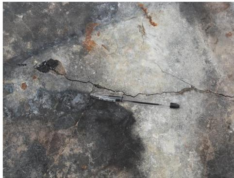
**FIGURE A.2** – Développement d’un réseau de fissure dans une dalle en béton suite à un feu [124].
