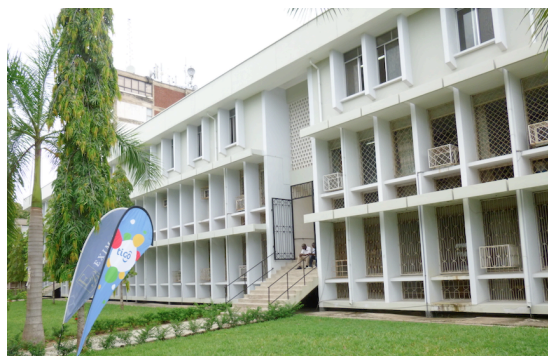
Aile en fin de construction du collège de sciences sociales 28/04/2013, Dar es Salaam © Olivier Provini
