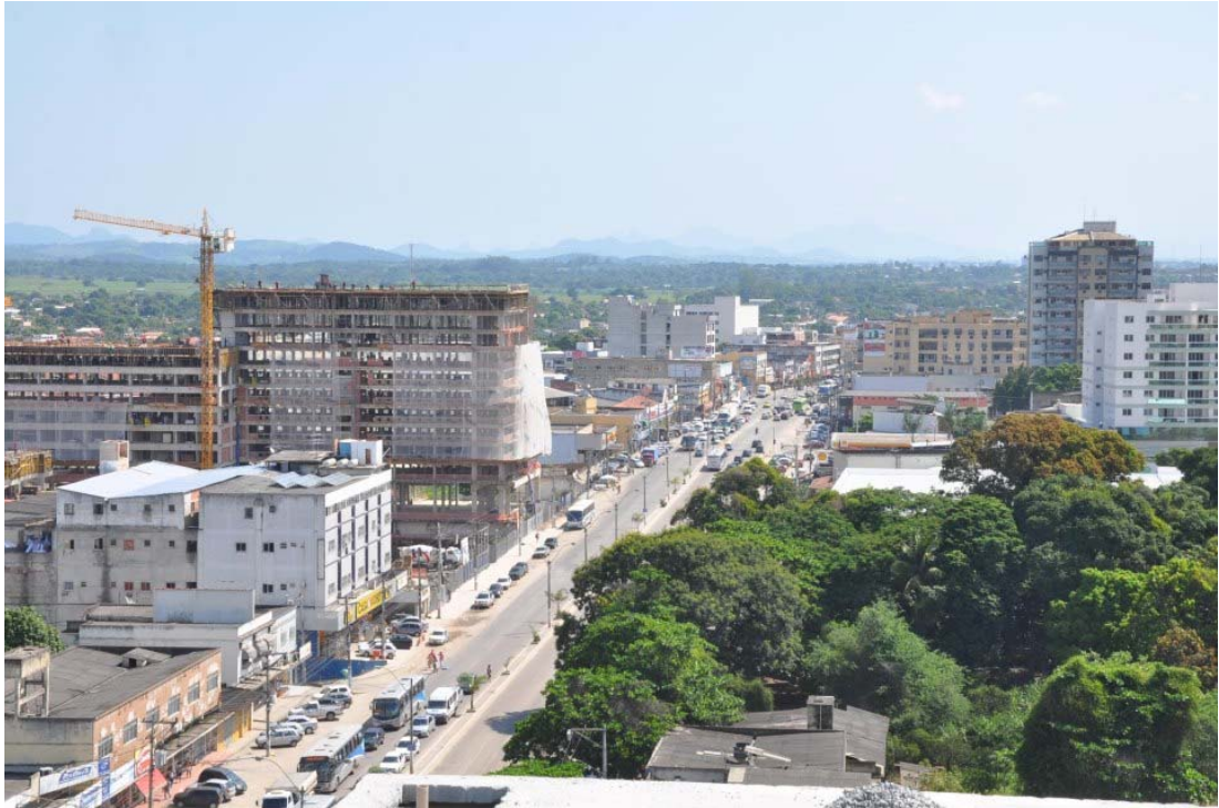
Figure 26 : Photo aérienne de l'axe routier principal d'Itaboraí 426
