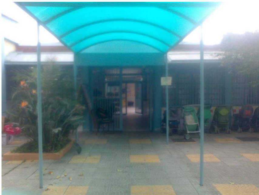
Figure 25 : Photo de l'entrée de la crèche Trindade (2014)
