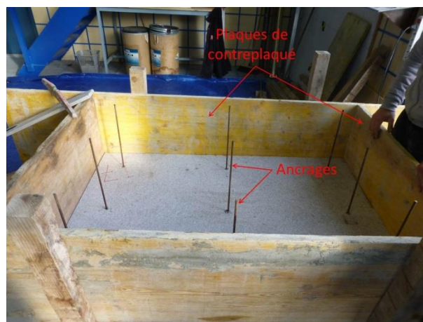
Figure 3-19 Coffrage de la partie inférieure de l'éprouvette
