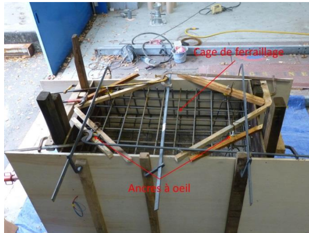
Figure 3-24 Epreuve prête à recevoir le deuxième coulage du béton après mise en place des armatures et du coffrage
