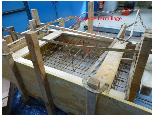
Figure 3-20 Bloc prêt à recevoir le béton après mise en place des armatures et du coffrage
