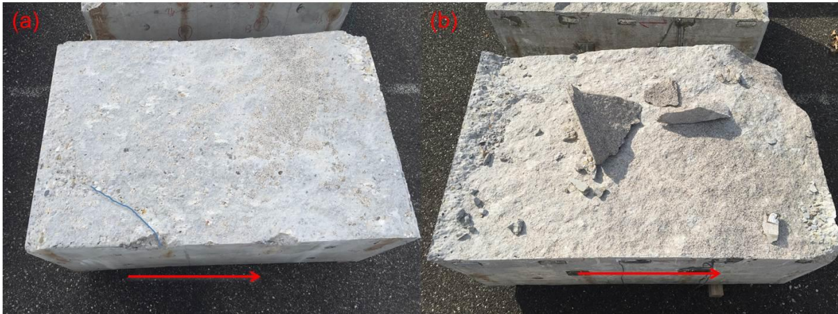
Figure 4-40 Etats des surfaces (a) du béton et (b) du granite du contact de l'éprouvette I2 après rupture
