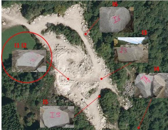
Figure 2-2 Vue de haut de la carrière et de la position de prélèvement de 2 blocs rocheux I1 et I2
