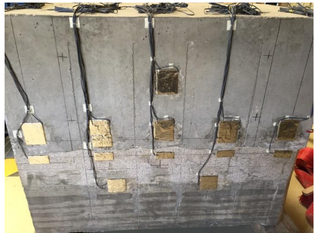
Figure 3-30 Protection des jauges
