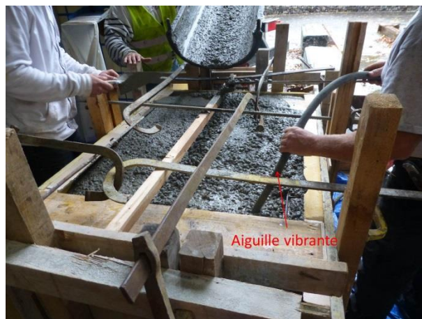
Figure 3-21 Coulage du béton de la partie inférieure de l'éprouvette
