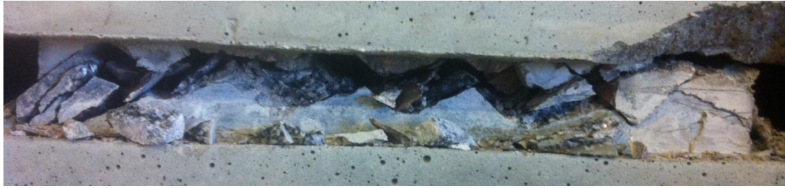
Figure 1-11 Etat de l'interface béton-roche non liée (aspérités à 40°) après essai de cisaillement (Gutiérrez 2013)
