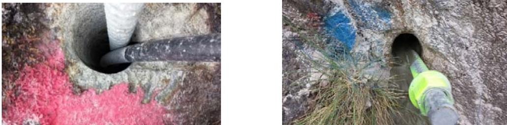
Figure 16. Exemples de position inadéquate de centreurs : a) barre excentrée en tête avant le scellement ; b) barre excentrée en tête après scellement.
