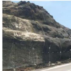
Figure 7 Filet/grillage plaqué ancré (CEMAGREF, 2004)
