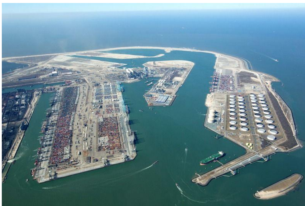
Figure 6.4. Maasvlakte 2 : une extension portuaire sur la mer
