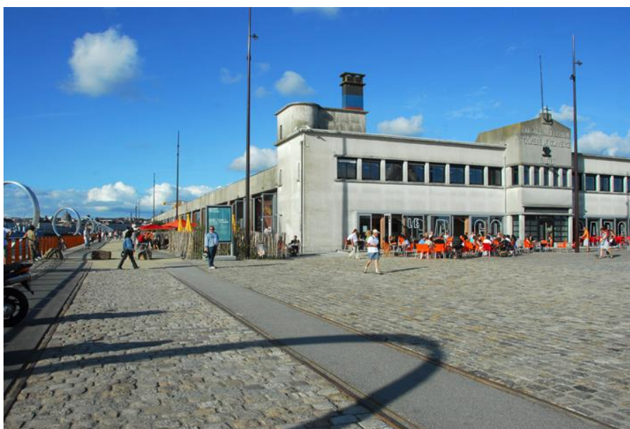
Figure 7.8. Nantes : le hangar à bananes
