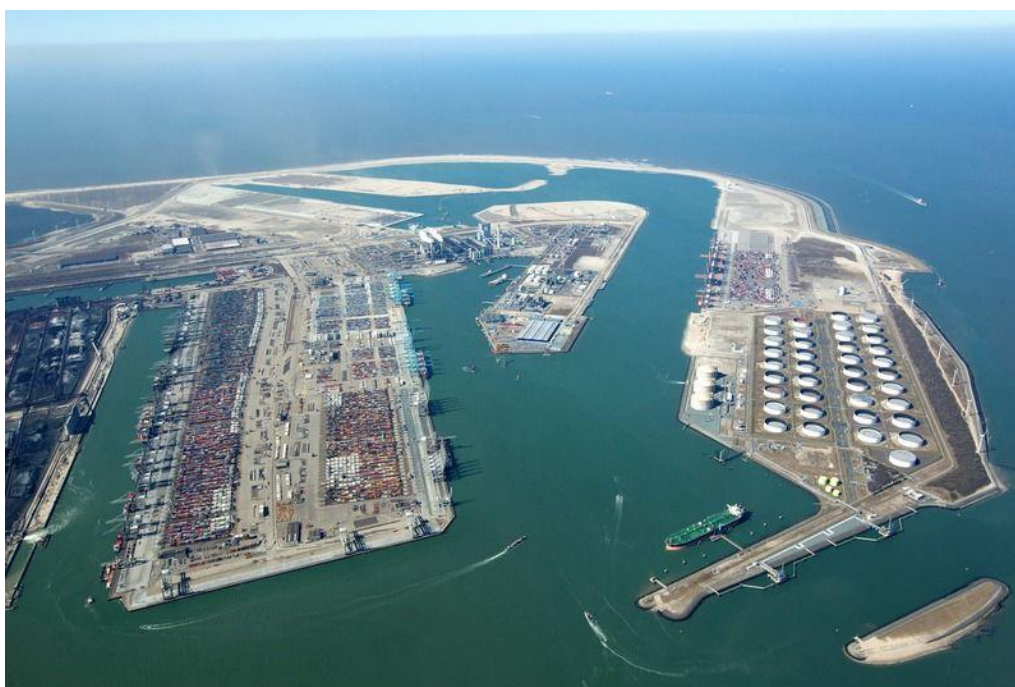
Figure 6.4. Maasvlakte 2 : une extension portuaire sur la mer
