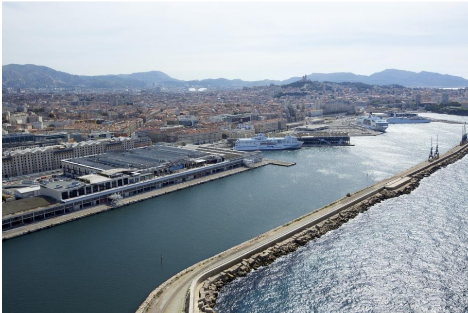
Figure 7.10. Marseille : un centre commercial sur le port
