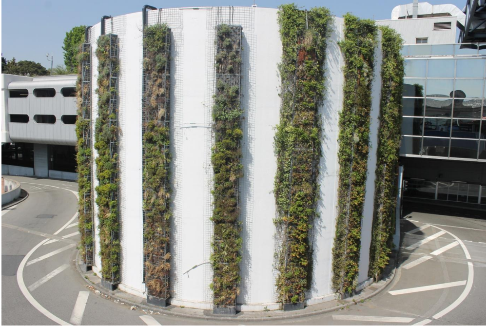
Photographie 2. Le mur végétalisé biofiltrant situé sur l'un des échangeurs de la gare de Perrache est envisagé comme étant l'une des réponses à des problématiques urbaines que constitue l'air pollué.
