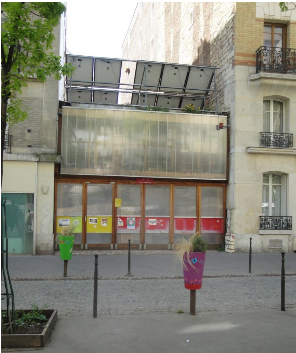
Figure 7-6. Façade extérieure du 56.
