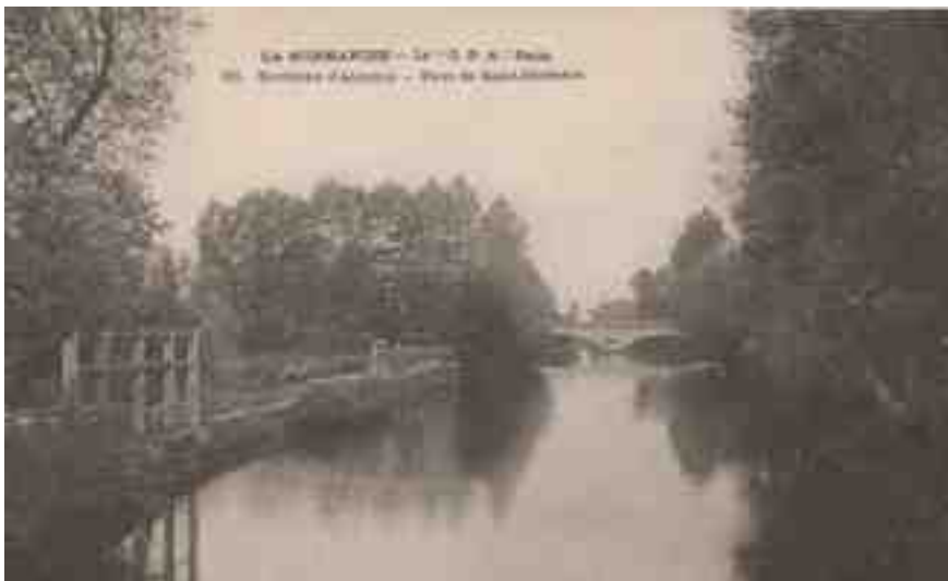
Illustration 47. Carte postale du début du XX e siècle montrant la passerelle sur le déversoir du moulin sur la gauche et plus loin sur la rivière, le nouveau pont, à Saint-Germain-du-Corbéis. Collection Maudet.
