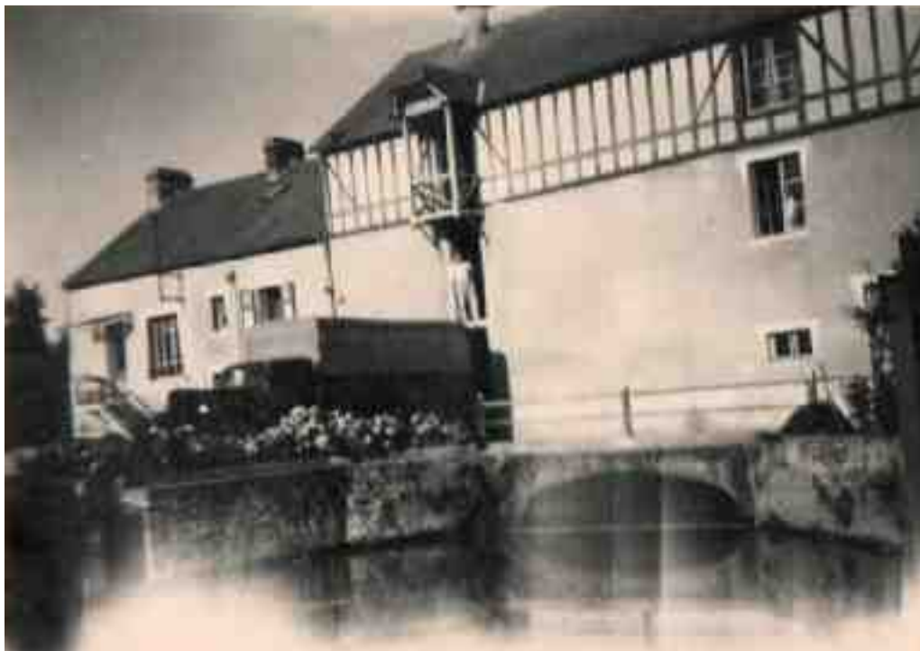
Illustration 68. Maurice Maudet posant au premier étage de son moulin en 1938. Collection Maudet.
