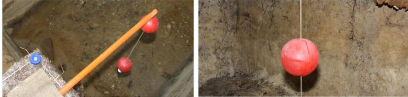
Le risque lié à cette fouille était l'éboulement des parois. Le sable très fluide, même retenu par des strates de sol induré, pouvait se défausser juste du fait des vibrations dues à l'équipe marchant autour du trou.
