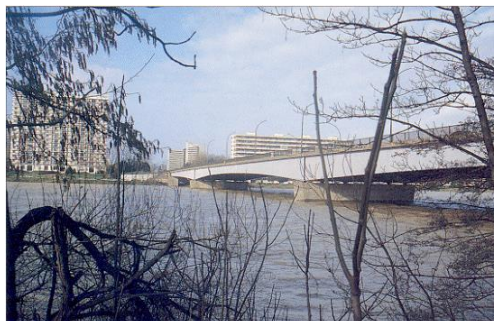
Pont Georges Clémenceau (photos Th. Mézerette)
