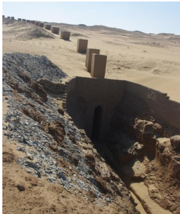
Figure 13 - Lignes de regards restaurés par l'IFAO et exutoire du qanât MQ5 à KS089 - Aïn Manawir. Cet ouvrage, comme la plupart des autres qanâts du site, a été remanié entre l'époque perse et la fin de l'époque romaine. Prise de vue : novembre 2012
