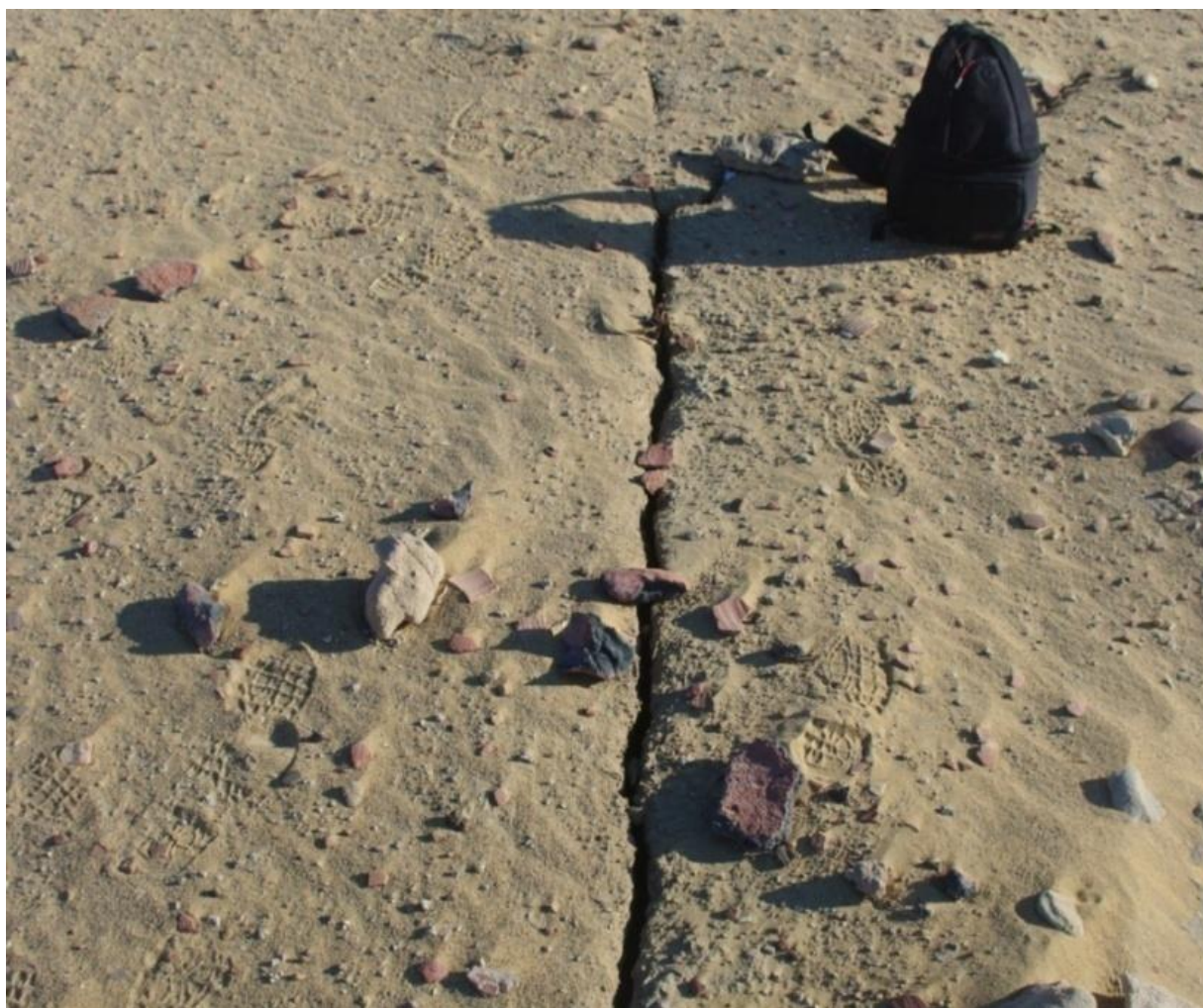
Figure 52 - Fentes de dessiccation observées à KS060 - Tell-Douch en décembre 2011. La plus longue observée sur le terrain a pu être suivie sur près de 20 m, et leur profondeur se limitait à quelques décimètres, voire un peu plus d'un mètre pour les plus importantes. Ces fentes constituent des points d'infiltration rapide pour l'eau météorique et semblent, par endroit au moins, avoir guidé les écoulements et favorisé le ravinement. Prise de vue : novembre 2012.
