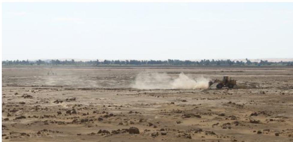
Figure 20 - Préparation de futures parcelles agricoles au sud du site de KS241 - Aïn Gaga entre Ezbet Gaga et Aden. Après un premier aplanissement à l'origine des marques visibles au premier plan et de la dispersion de débris de yardangs, une pelle mécanique, au second plan, finit le travail. L'oasis visible au fond est Aïn Tafnis. Enfin, au dernier plan, les collines de KS060 - Tell-Douch (à gauche) et de KS089 - Aïn Manawir (à droite) s'élèvent au-dessus du fond de la dépression. Photographie : Tiphaine Dachy, novembre 2012.
