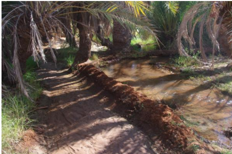
Figure 6 - Canaux d'irrigation dans l'oasis actuelle de Douch. Formé directement sur le substrat sablo-limoneux et délimité par des bourrelets de terre amovibles, il permet l'acheminement et le partage de l'eau entre les différentes parties de l'oasis. Le canal situé à gauche n'était pas en eau à cette période, mais un simple coup de houe, suivi de la formation d'un nouveau bourrelet dans le canal de droite permet de dévier l'eau vers d'autres secteurs. Prise de vue : novembre 2011.
