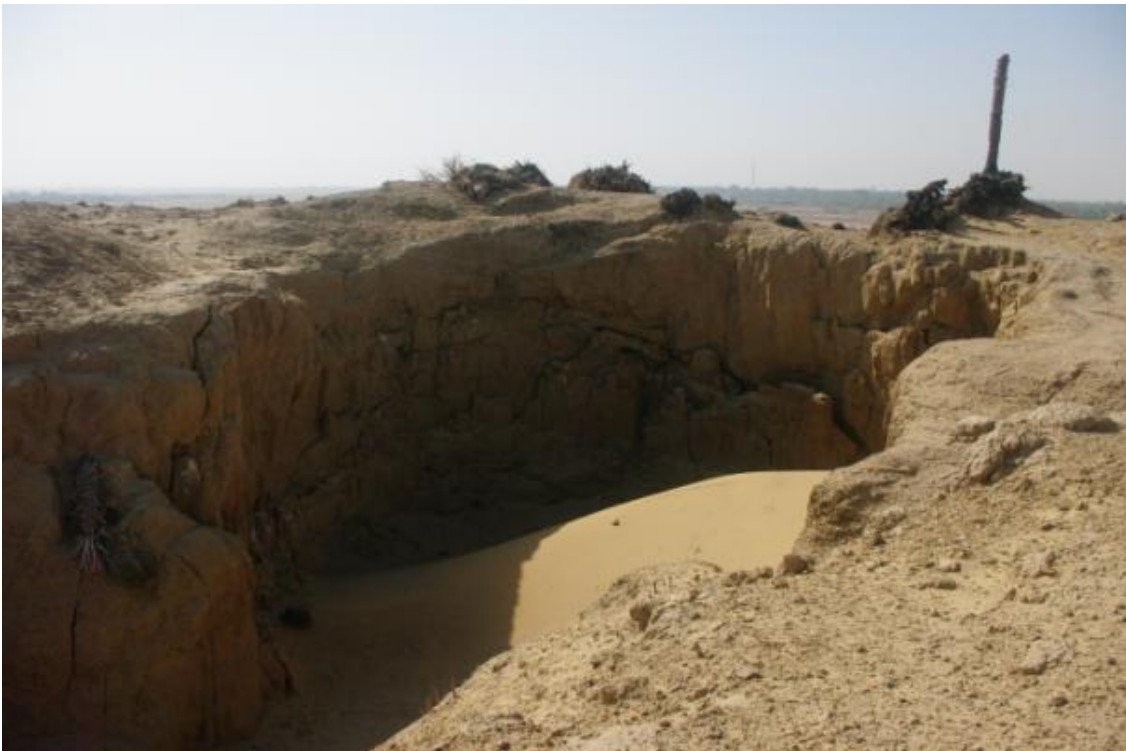
Figure 18 - Cuve ensablée et début du chenal (en bas à gauche) du puits d'Aïn el-Matrahiyya. La berge de rétention d'eau n'a pas été conservée. Prise de vue : novembre 2014.
